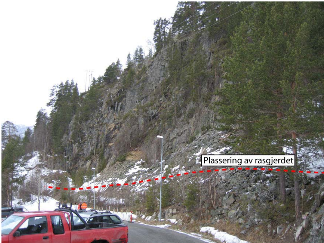
Bilde 2. Fjellside og ur som skal sikres med rasgjerde.
