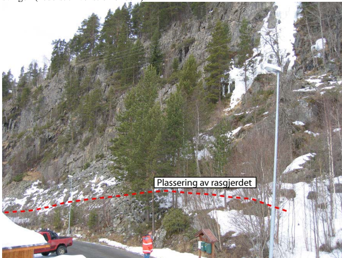
Bilde 1. Fjellside og ur som skal sikres med rasgjerde.
