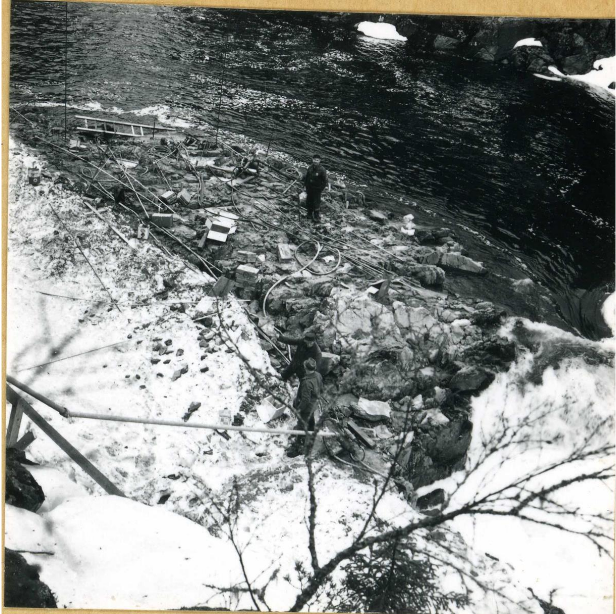
Her blir det gjort klar for sprenging av fossen mellom hylane.
