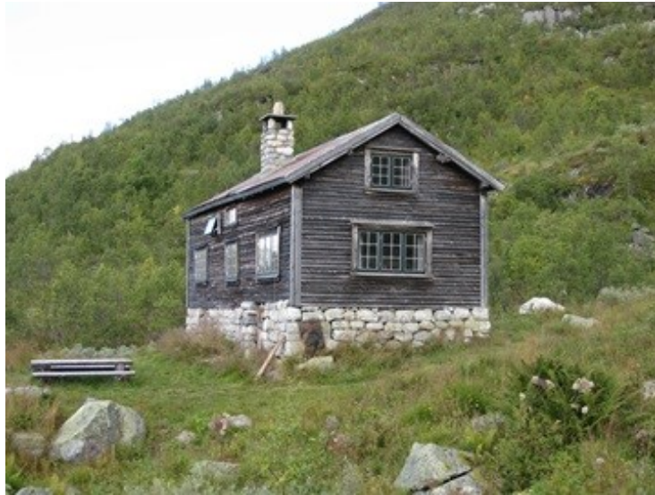
Berunuten før opprusting
