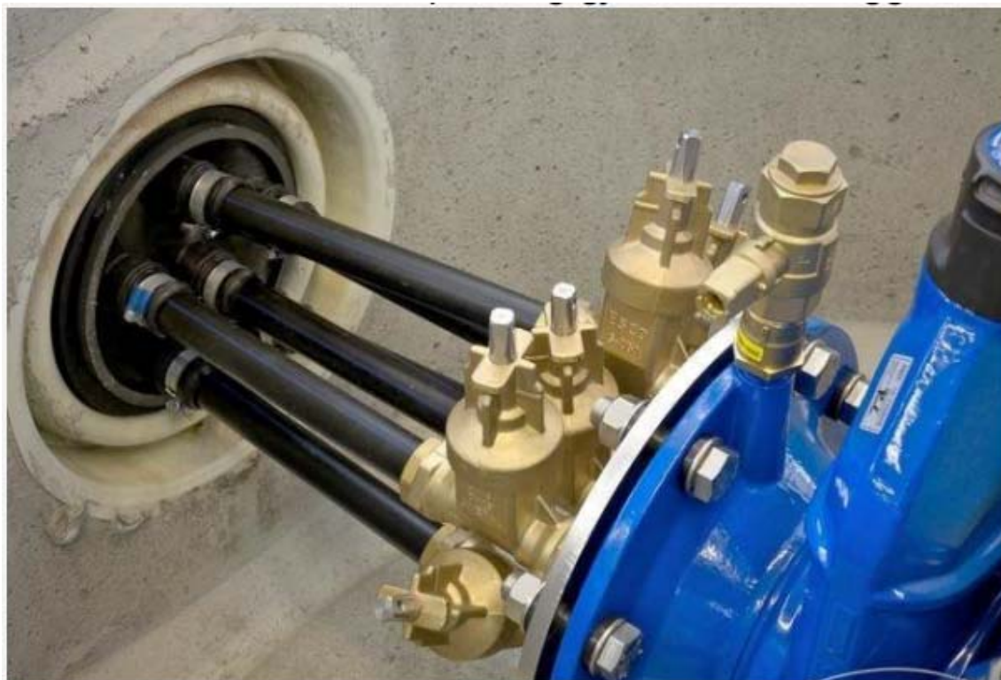
Bilde 6: Bildet viser eksempel på manifold. Bildet er hentet fra betongprodusenten Skjæveland.
